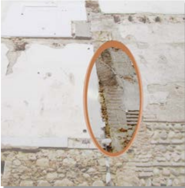
Aperçu d'un cintre en cayrou... On a retrouvé le porche d'entrée de l'église !
