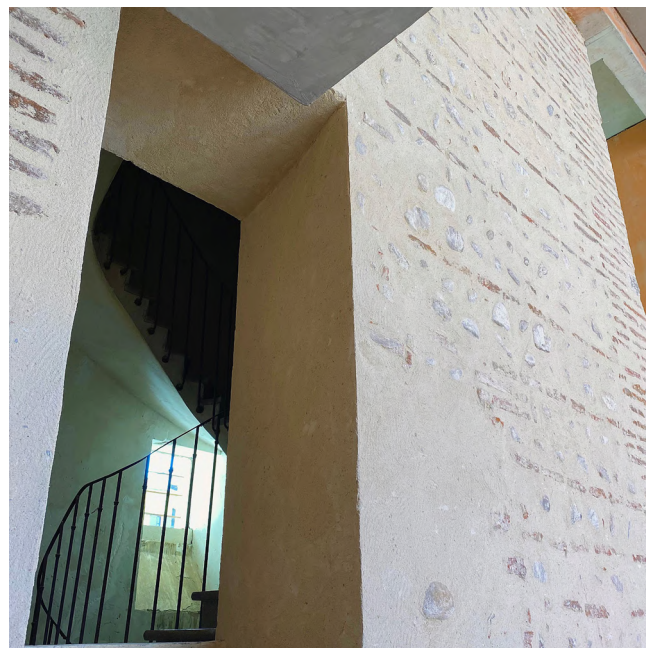
L'escalier intérieur du clocher est inaccessible aux étudiants, mais reste visible en traversant les étages
