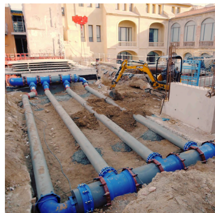
Puits climatique Températures à l'entrée : de 3° à 30° Températures en sortie : de 10° à 25°
