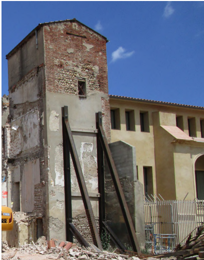
Mise en place d'étais provisoires de soutènement
