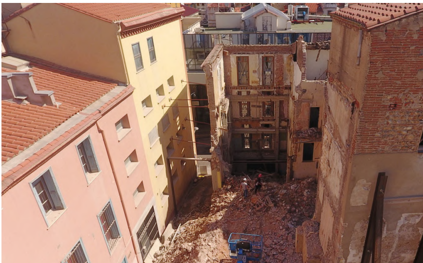
Évidement des immeubles vu depuis le haut de la rue Côte Saint-Sauveur
