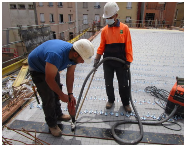
Aspiration des poussières pour éviter leur propagation dans l'air
