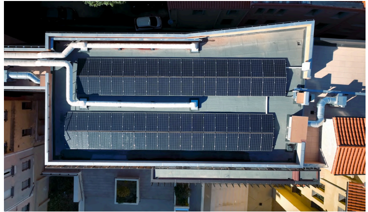
Installation sur le toit du bâtiment de l'amphithéâtre
