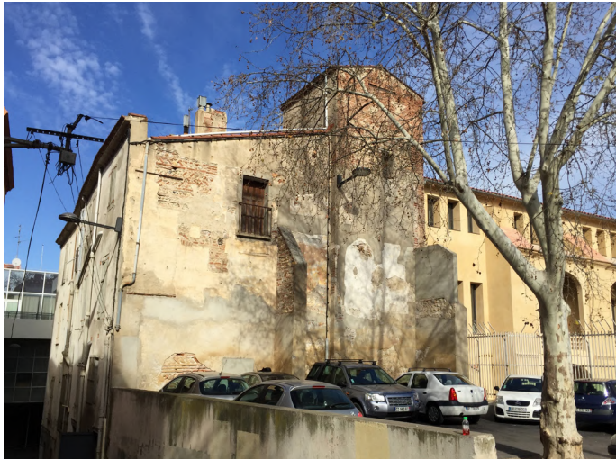
Vue de la rue Côte Saint-Sauveur avant travaux, le clocher s'appuie sur les immeubles adjacents.
