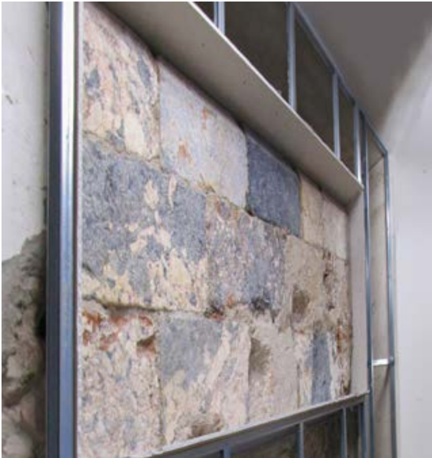
① Encadrement de l'emplacement de l'ancien où l'on distingue les emplacements des soutiens des marches
