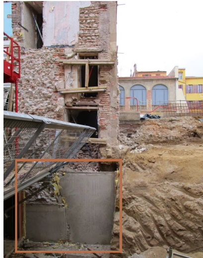
Reprise en sous-œuvre des fondations
