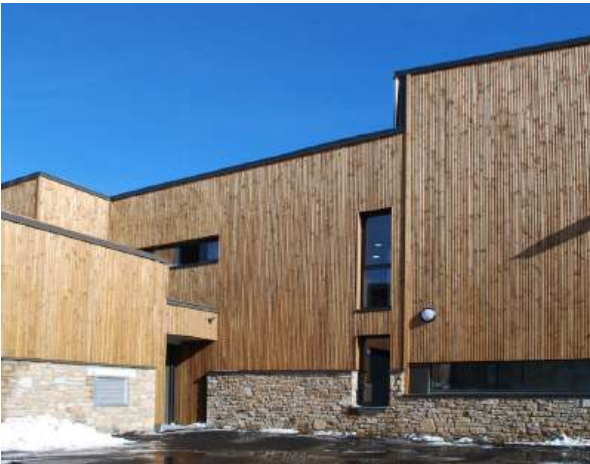
Soubassement pierres et bardage bois
