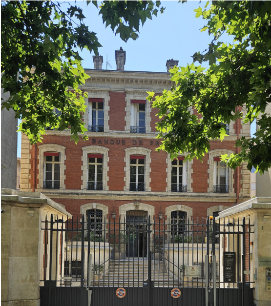
Façade nord du bâtiment existant
